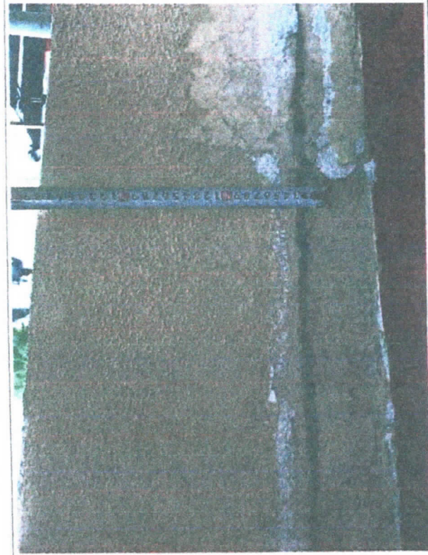
Образование деформационных трещин между Ж/Б колонной входной группы и здания (12мм)
